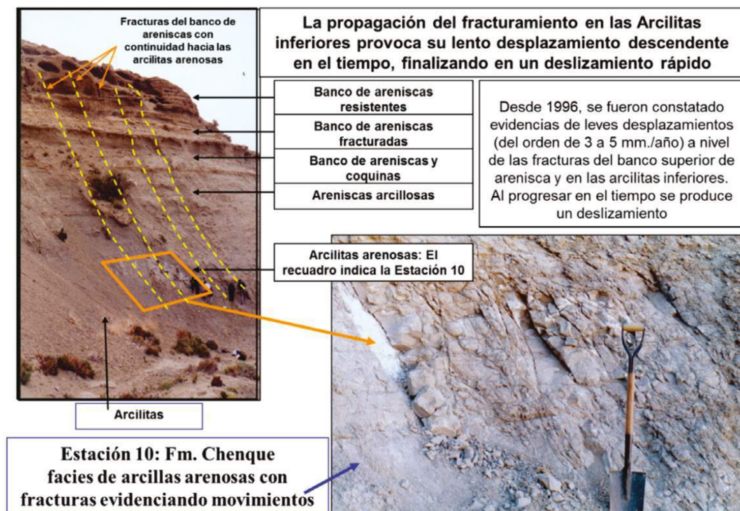
Figura 6. Faldeo Sur del Cerro Chenque, sobre calle Sarmiento, entre calle Mitre y Ruta Nacional N° 3. Izquierda: fracturas que se propagan por las arcililas descalzando los bancos de areniscas superiores. Derecha: detalle del carácter ondulado de los planos de fractura a gran escala pero a la vez lisos en su superficie, lo que favorece los desplazamientos.
