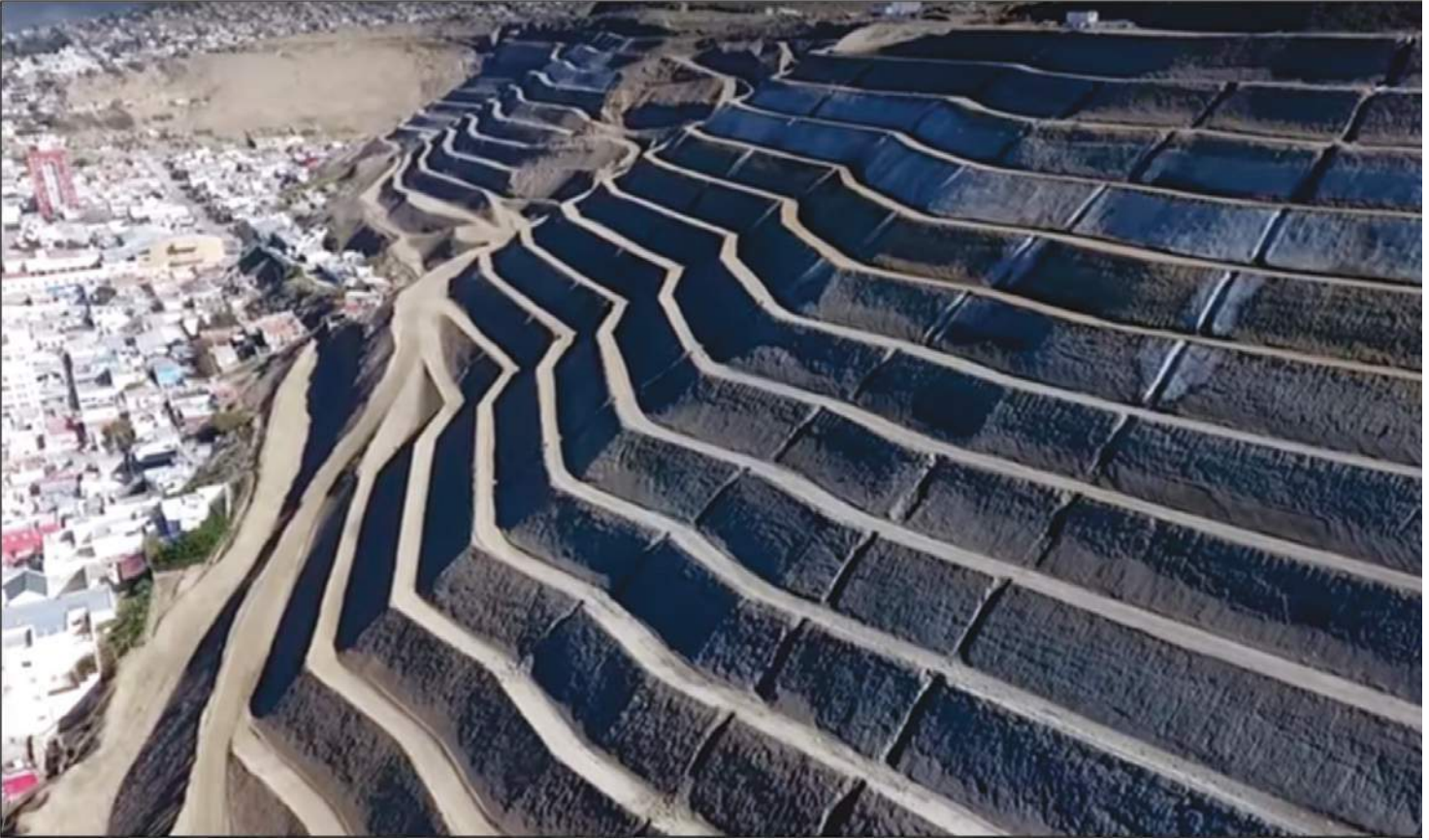
Figura 12. Vista general desde el este del tramo inferior y medio del aterrazamiento del Cerro Chenque. Notar el gunitado incompleto del aterrazamiento y de las canaletas de drenaje.
