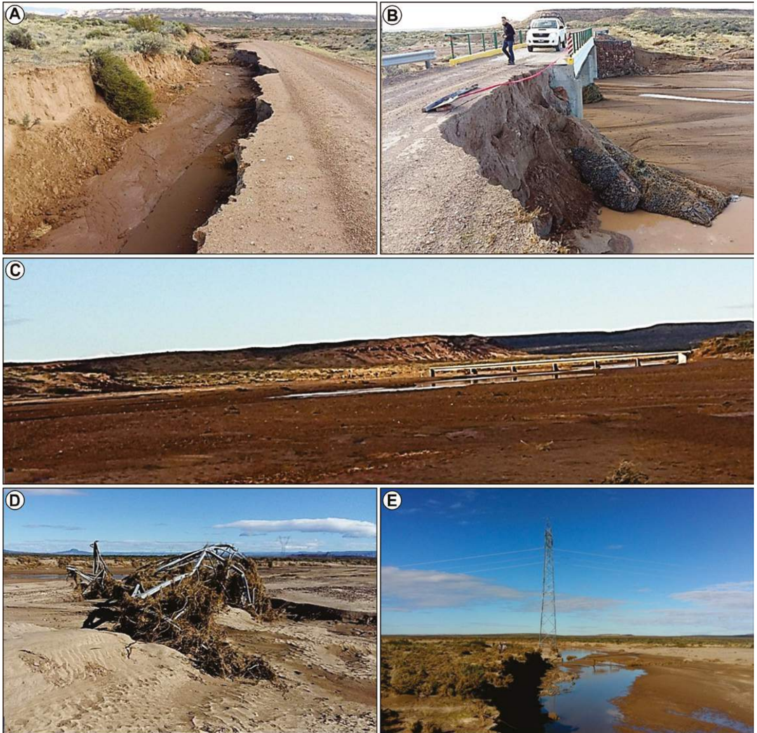
Figura 13. (A) Desarrollo de erosión con formación de cárcava en la banquina de la Ruta Prov. N° 59, (B) erosión del terraplén de aproximación de margen izquierda del puente de la Ruta Prov. N° 59 sobre el Arroyo Ponte, (C) vista desde aguas abajo del puente de la R.P. N° 59 sobre el Arroyo Perdido, (D) Torre 887/N de la línea de alta tensión Futaleufú-Aluar que fue derribada por la corriente y arrastrada 500 metros, (E) vista desde aguas arriba de la torre 885/S con importante erosión de la fundación.
