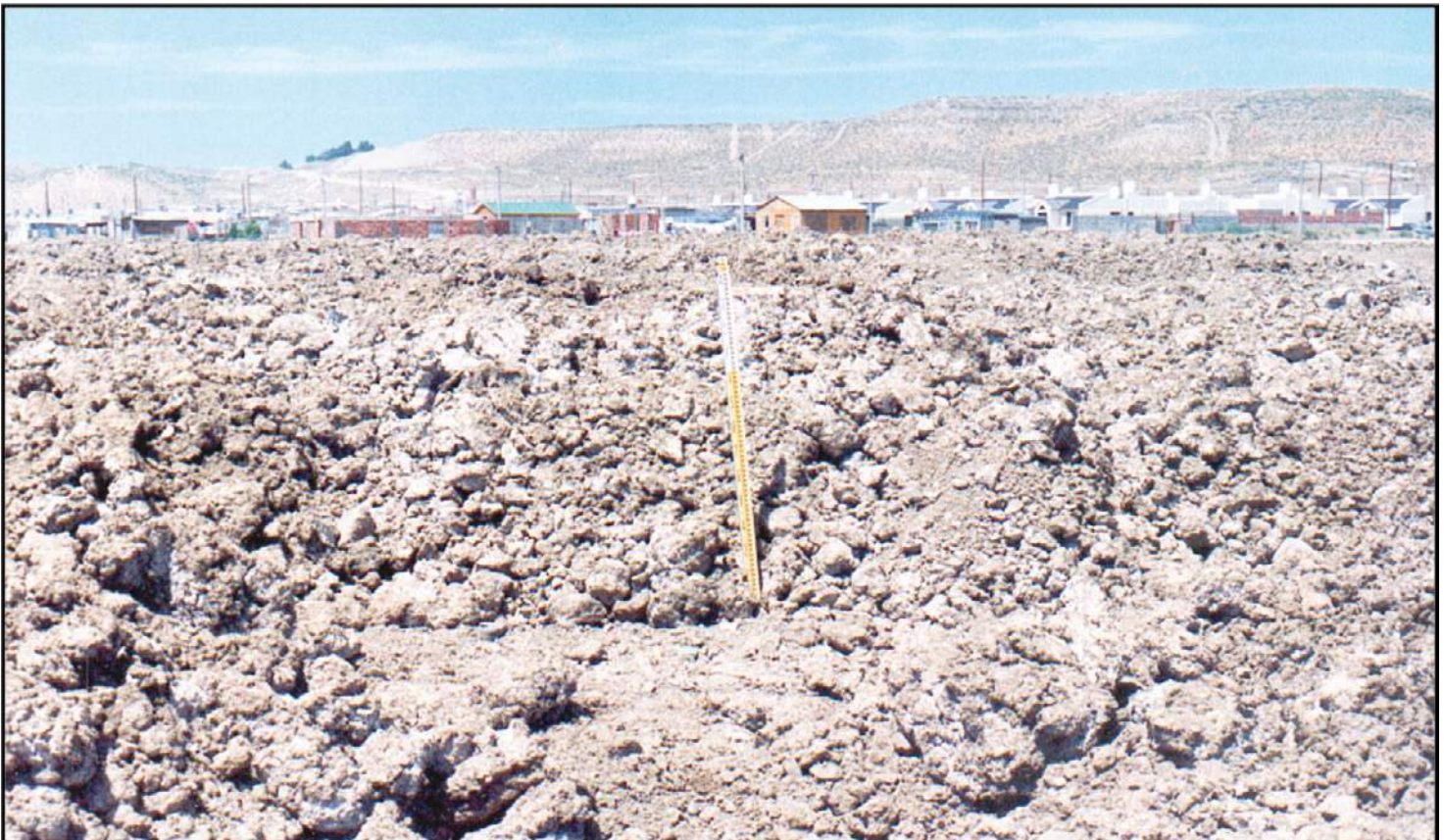
Figura 7. Sobre este material, de granulometría fina y alto contenido salino, depositado y posteriormente compactado, se desarrollaron los nuevos barrios hacia el Suroeste. Grizinik y Hirtz (1997b).
