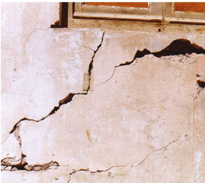
Figura 8. Casa muy antigua en Pellegrini y Sarmiento. Pulsos de movimiento acumulados generaron un severo agrietamiento a 45°. Se instalaron comparadores a ambos lados de la fractura para monitorear los desplazamientos en el tiempo.
