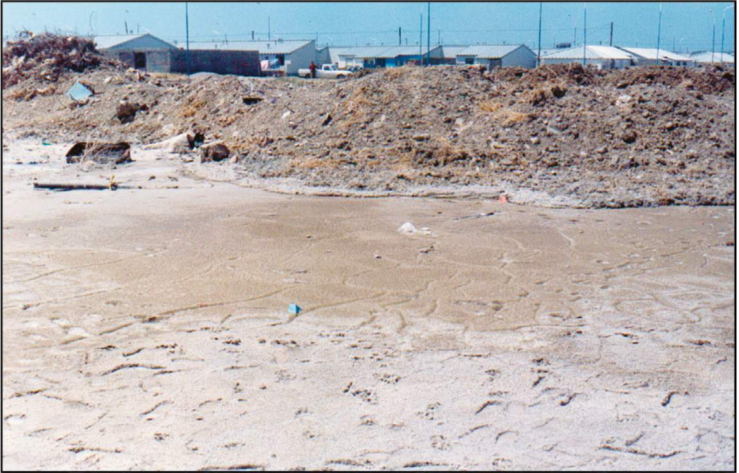
Figura 6. El material extraído para confeccionar los drenes de los Barrios Niaco y Juan XXIII, fue depositándose sobre el bajo salinizado, dificultando el drenaje superficial del agua hacia el Este, en lo que era su escurrimiento natural hacia el mar. Grizinik y Hirtz (1997a, 1997b).
