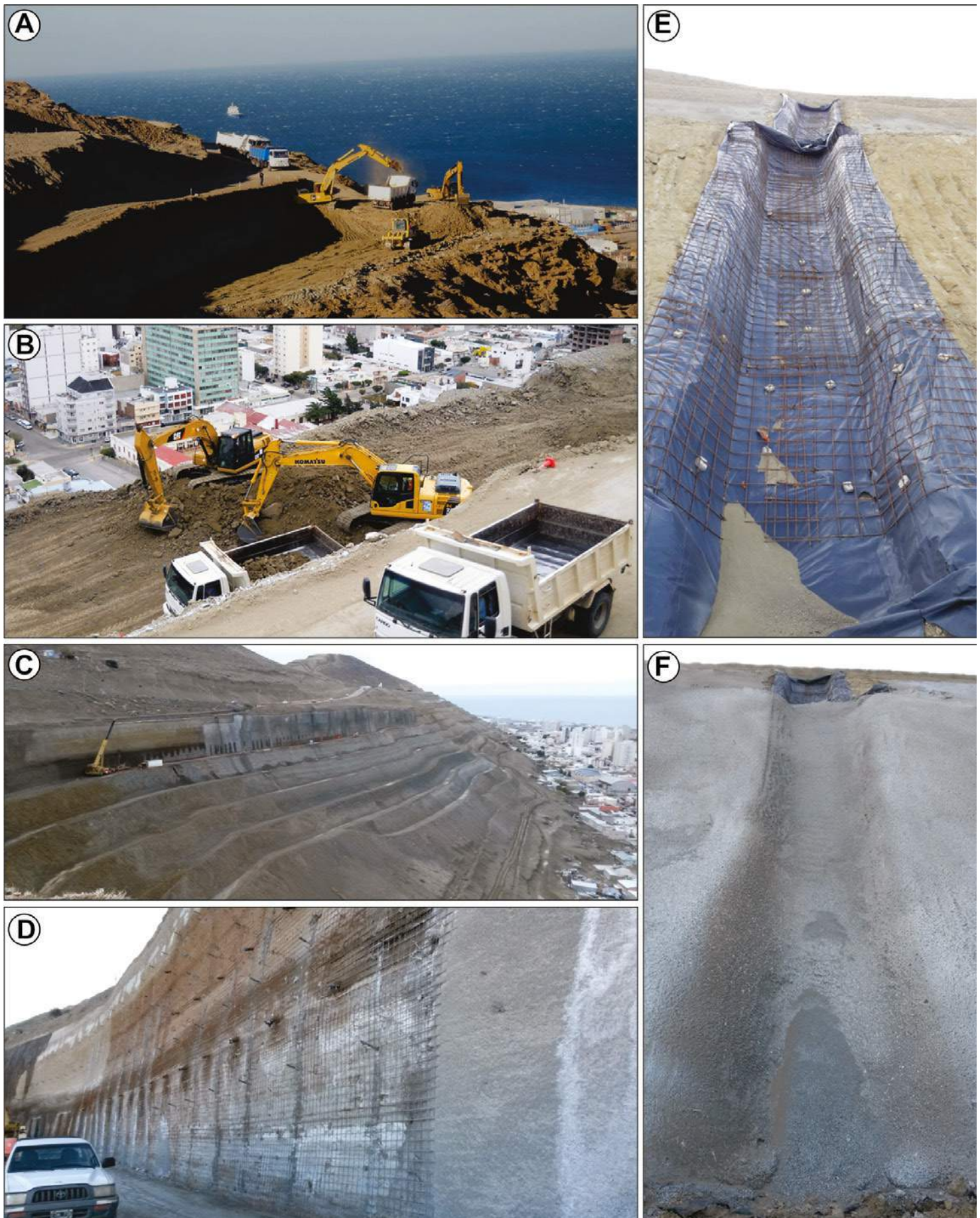
Figura 11. Principales tareas de aterrazamiento, acondicionamiento y protección del sector de escalonamiento. (A) Extracción de las areniscas que conformaban la antigua saliente topográfica del Mirador. (B) Extracción de materiales en el tramo medio. (C,D) Avance de obra durante el perfilado del banco de areniscas, cercano al sector del “Balcón”. (E,F) Confección y revestimiento de las canaletas; en E fase de excavación y revestimiento con membrana impermeable y malla metálica, en F se muestra la canaleta protegida mediante el proceso de gunitado.
