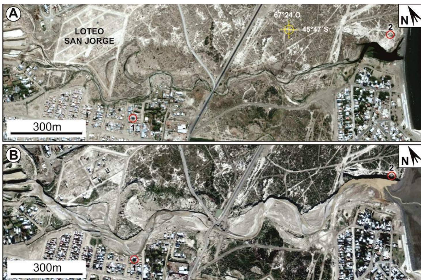
Figura 7. Desembocadura del arroyo de Restinga Alí (Km. 8). (A) Imagen de GoogleTM previa al temporal (18 de enero de 2017). (B) Imagen de GoogleTM posterior al temporal (23 de agosto de 2017). En el círculo rojo indicado con (1), se muestra una construcción que se encontraba a 71 metros del arroyo, y que luego de la tormenta quedó ubicada exactamente en el margen sur del cauce activo; en (2) se destaca la rectificación de la desembocadura, que involucró el desplazamiento de 72 m de la margen norte.
