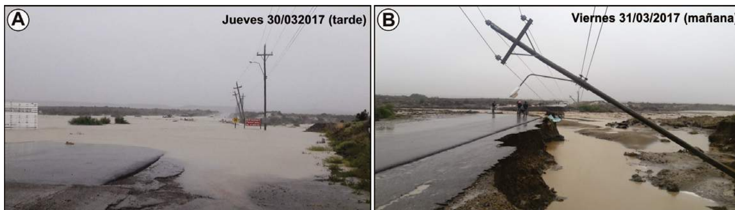
Figura 22. Ruta Provincial N°1 sobre el puente en Km. 8. (A) Los caudales exceden la capacidad evacuadora. (B) El puente fue finalmente destruido y los niveles de agua bajaron. Modificado de Foix et al. (2017).
